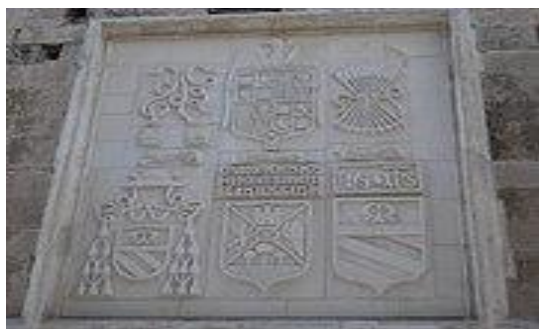
Escudos de la fachada este de la Iglesia de Santiago, destruidos durante la guerra civil, y restaurados en 2007
